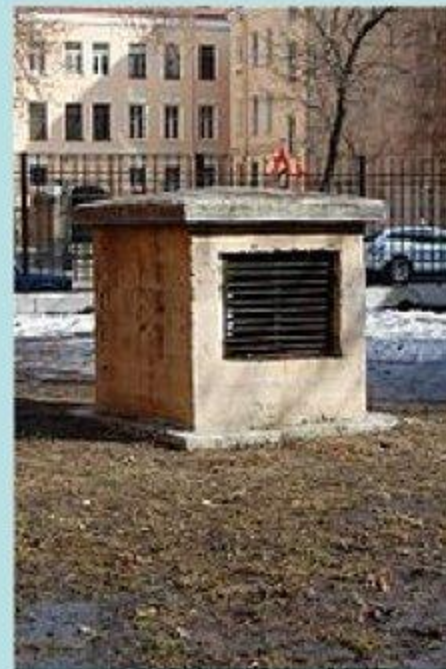
Оголовок аварийного выхода
