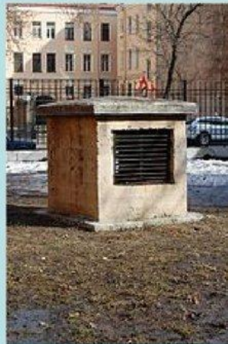
Оголовок аварийного выхода
