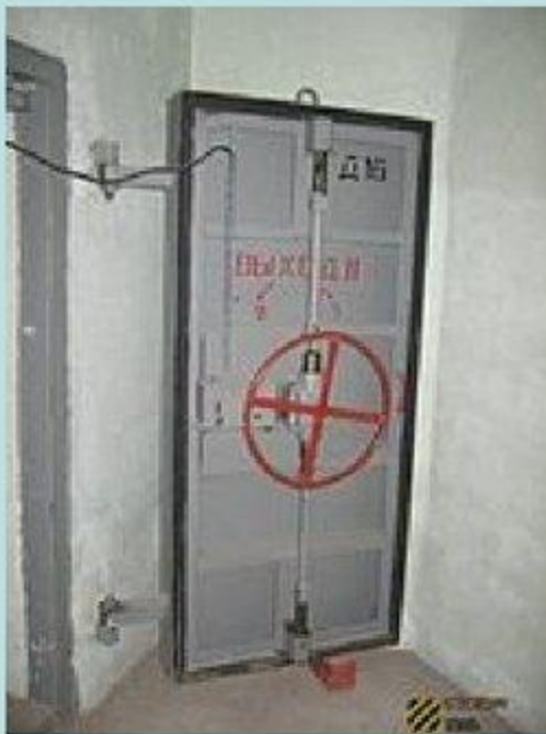
Защитно- герметическая дверь.
