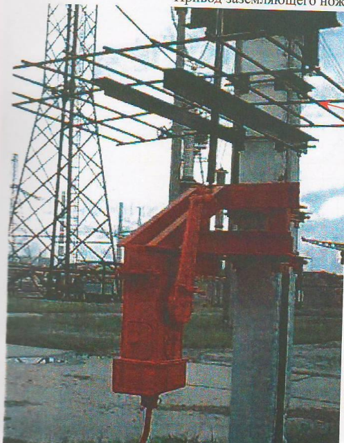
Привод заземляющего ножа
