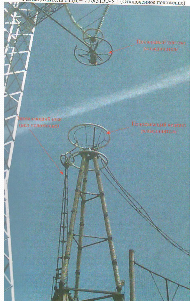
Разъединитель РПД – 750/3150-У1 (Отключенное положение)
