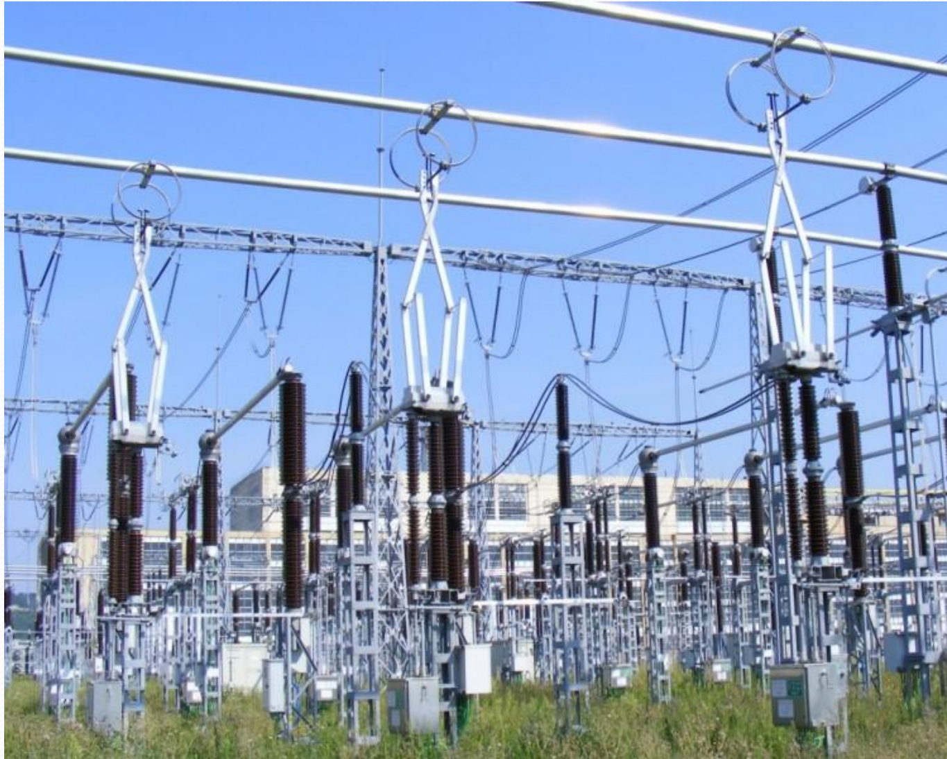
Роз'єднувач панторгафної дії типу P RF\RL
