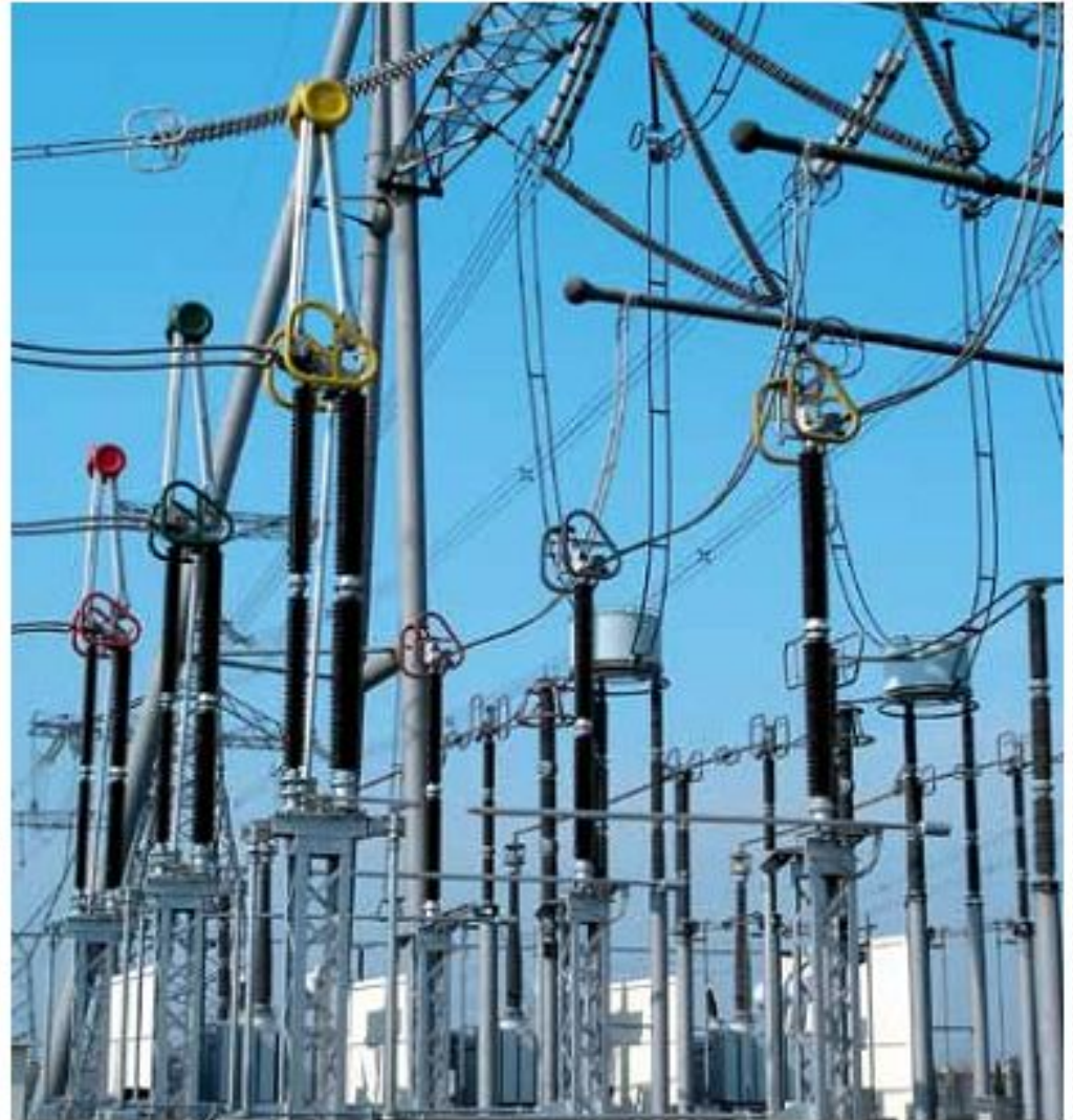
Роз'єднувачі вохрозривної дії та напівпанторгаф
