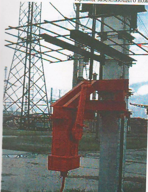
Привод заземляющего ножа
