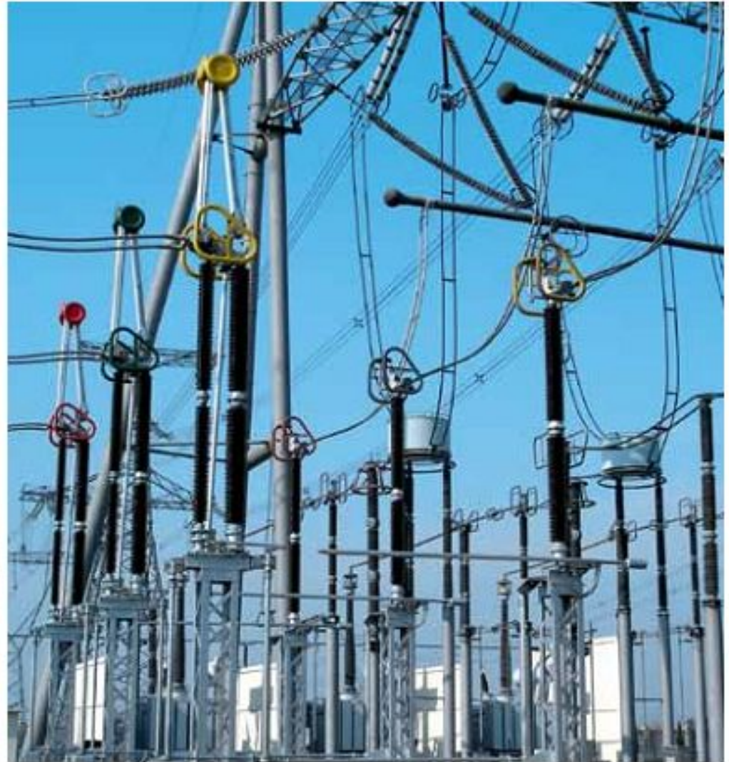
Роз'єднувачі вохрозривної дії та напівпанторгаф
