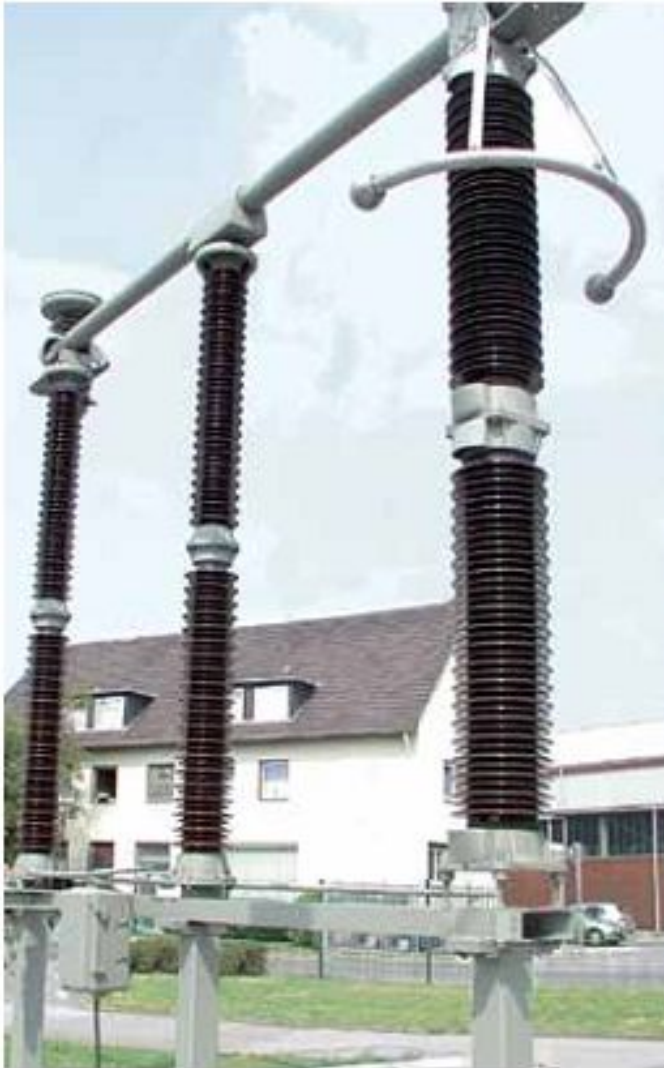
Роз'єднувачі вохрозривної дії та напівпанторгаф
