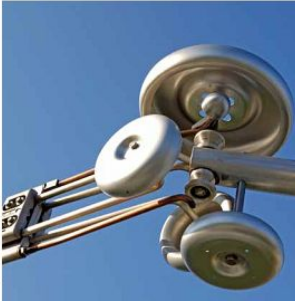
Роз'єднувач горизонтально-поворотної дії тип D BF
