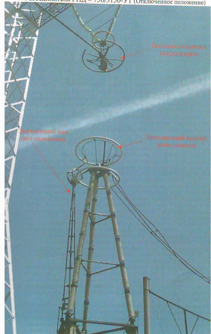
Разъединитель РПД – 750/3150-У1 (Отключенное положение)
