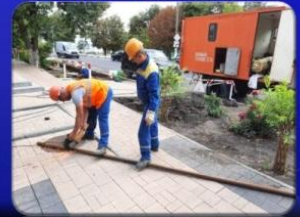
Проведение ремонтных работ ПП «Восточные тепловые сети»
