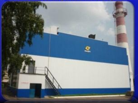
Котельная Центральная г. Валуйки
