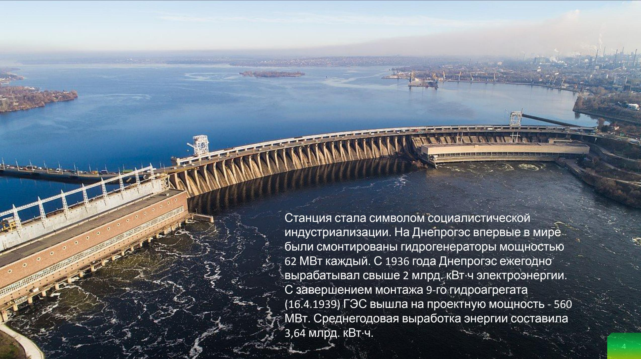
Станция стала символом социалистической индустриализации. На Днепрогэс впервые в мире были смонтированы гидрогенераторы мощностью 62 МВт каждый. С 1936 года Днепрогэс ежегодно вырабатывал свыше 2 млрд. кВт·ч электроэнергии. С завершением монтажа 9-го гидроагрегата (16.4.1939) ГЭС вышла на проектную мощность - 560 МВт. Среднегодовая выработка энергии составила 3,64 млрд. кВт·ч.
