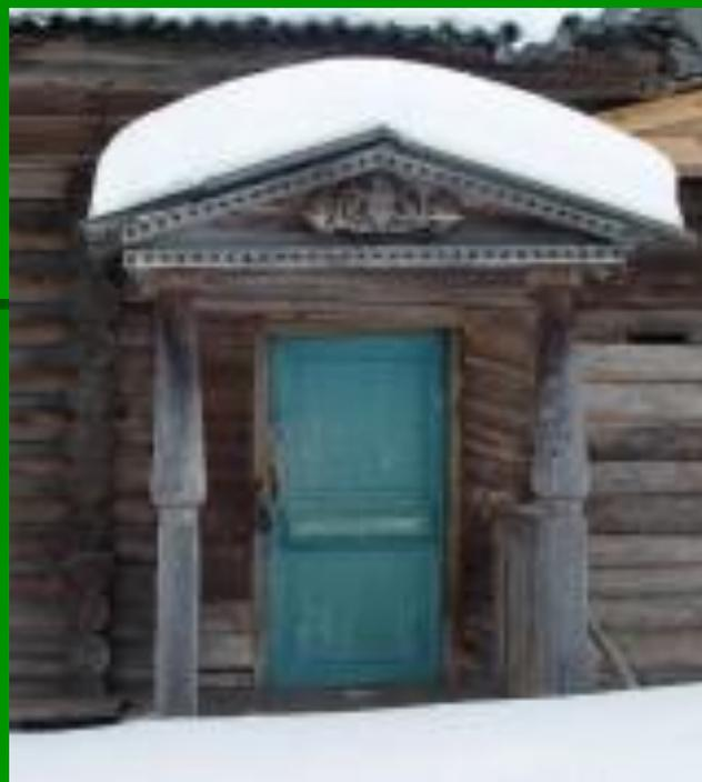
Подзор Подзор или карнизная доска — в архитектуре декоративная (резная) доска простой или сложной конструкции, окаймляющая свесы выступающих частей дома.
