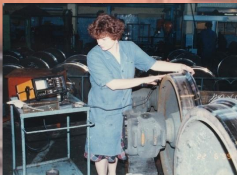
УЗК наплавленных гребней
