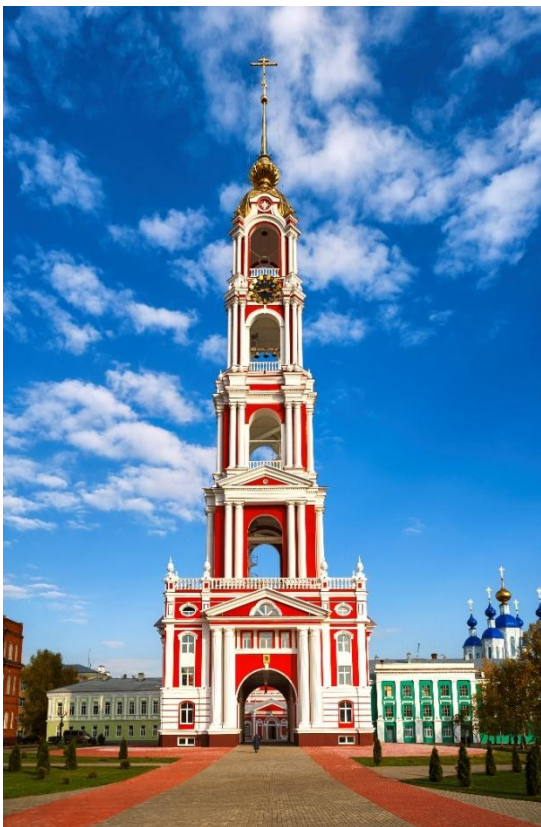
Колокольня Казанского монастыря. Строительство началось в 2009 году.
