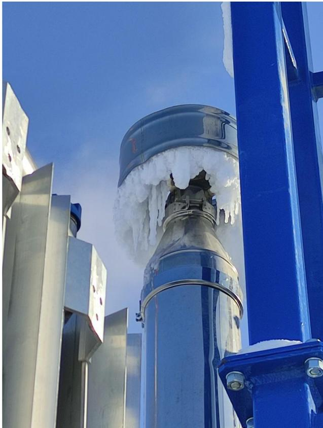
Наледь на выхлопной трубе генератора. Не мешает его работе (лед периодически падает)
