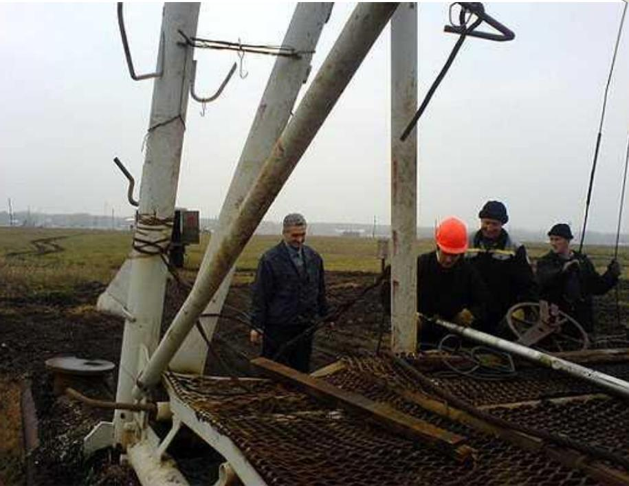
**Подсоединение кабельного наконечника к скважинному
