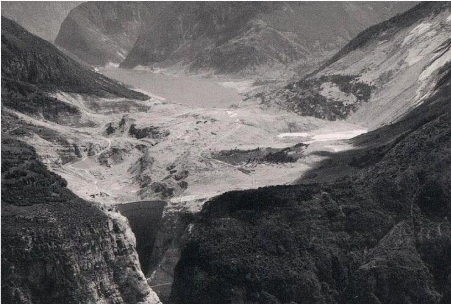
Катастрофа на плотине Вайонт, 1963
