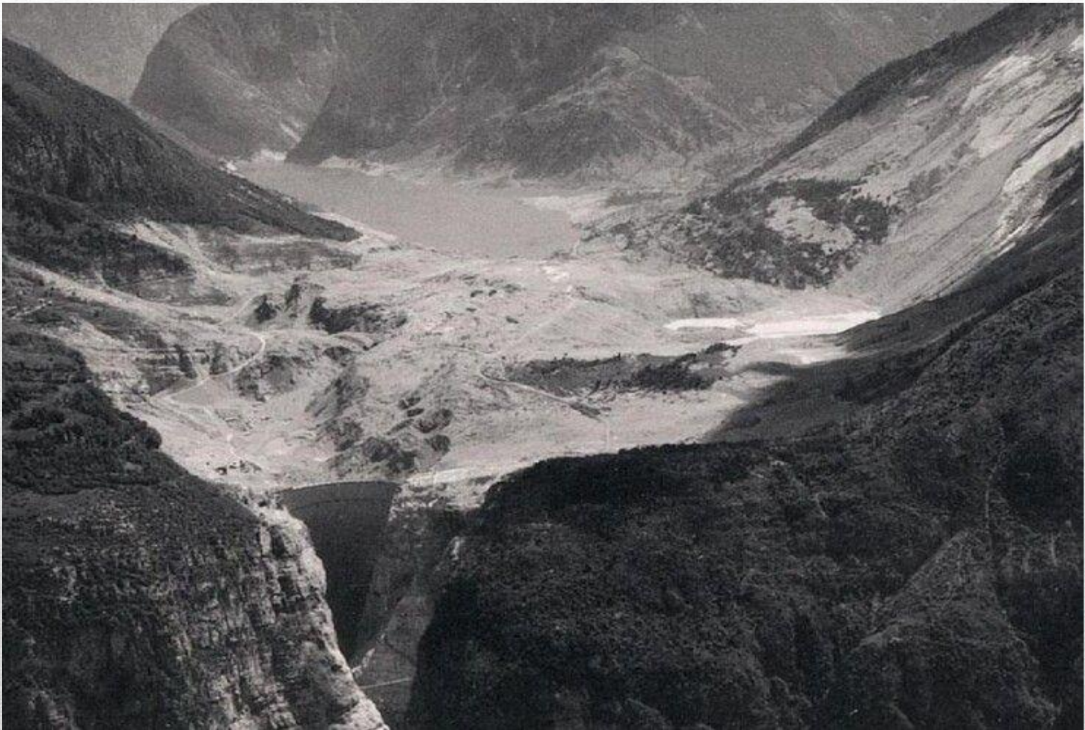
Катастрофа на плотине Вайонт, 1963
