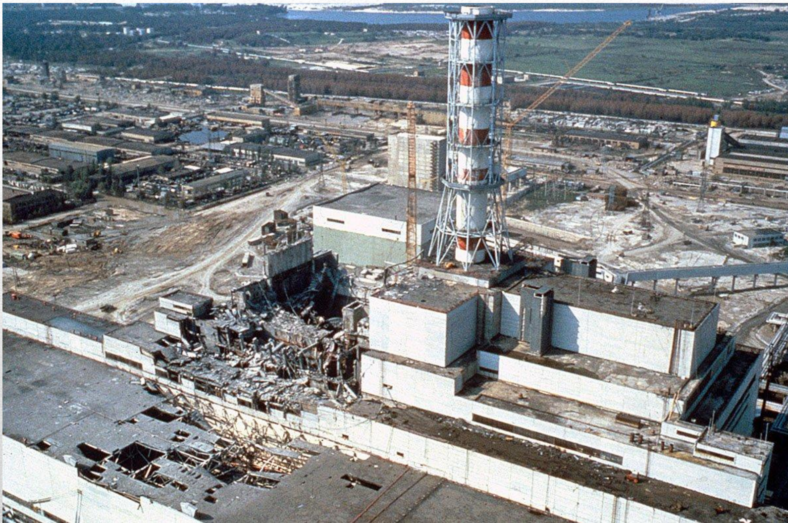
Авария на Чернобыльской АЭС, 1986
