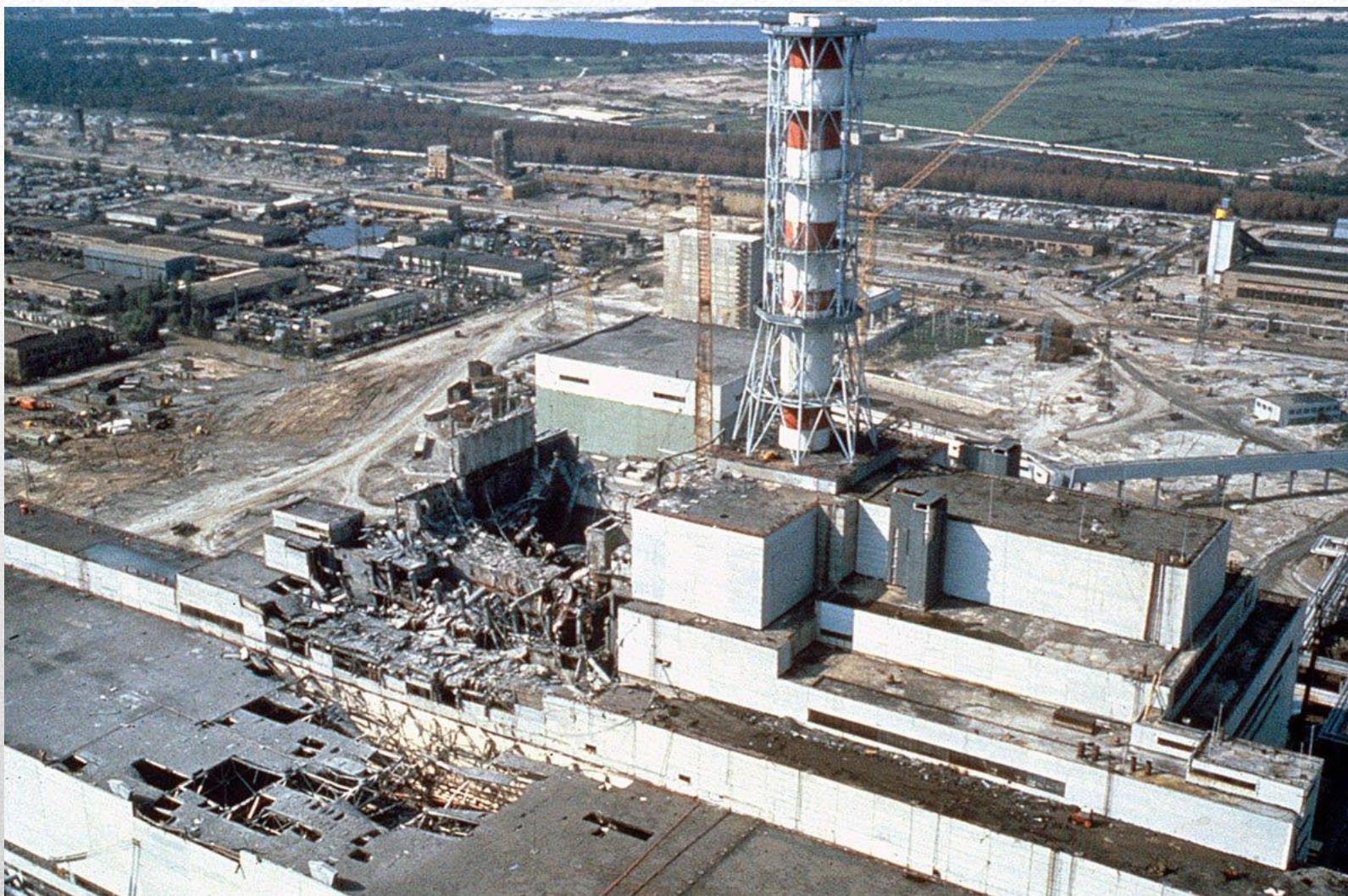
Авария на Чернобыльской АЭС, 1986
