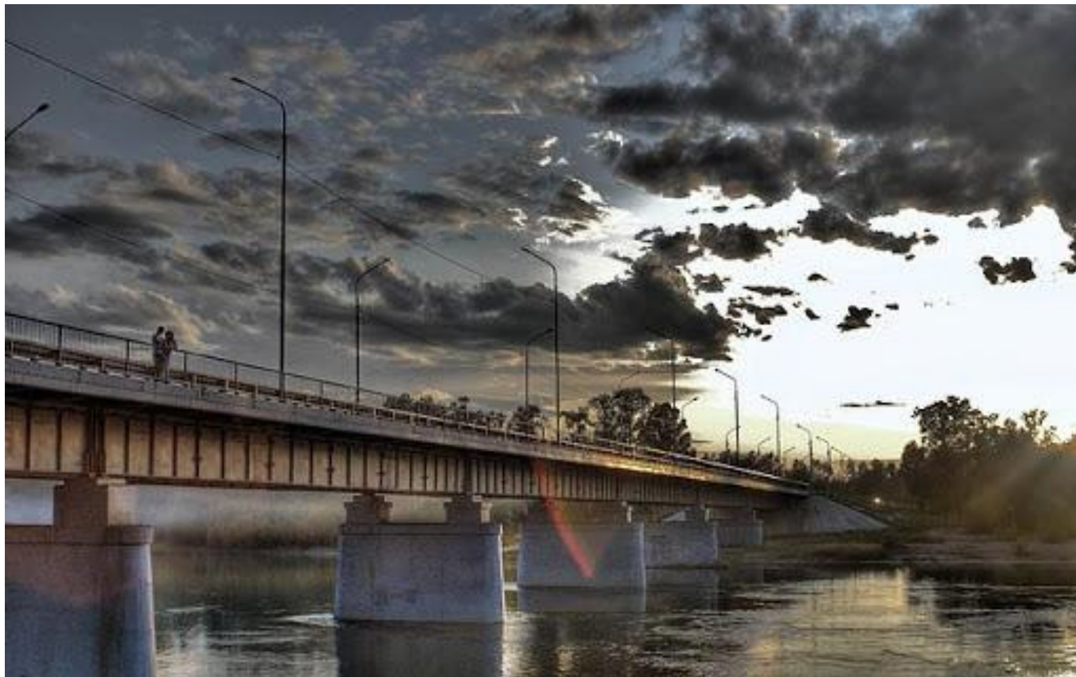
Автомобильный мост, через реку Китой г. Ангарск
