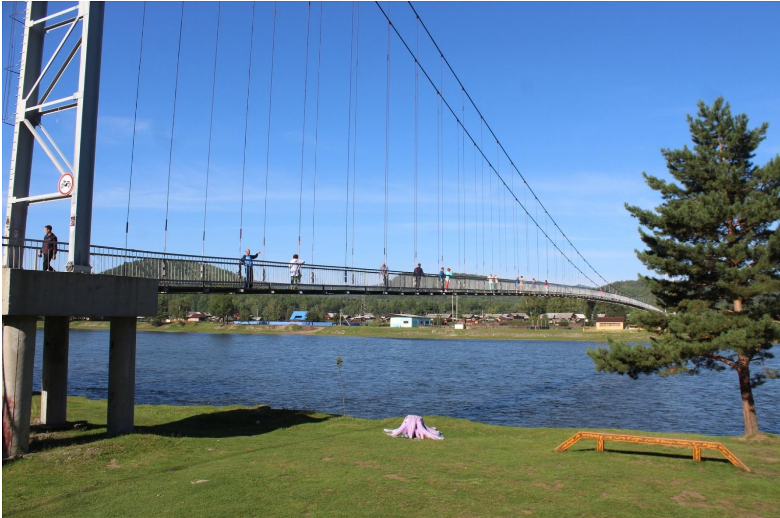
Пешеходный мост, через реку Иркут, возле посёлка Шаманка
