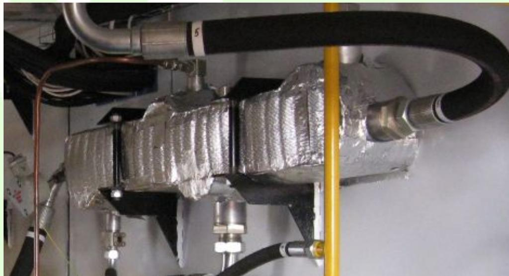
Конденсатор тяжелых фракций попутного нефтяного газа,
