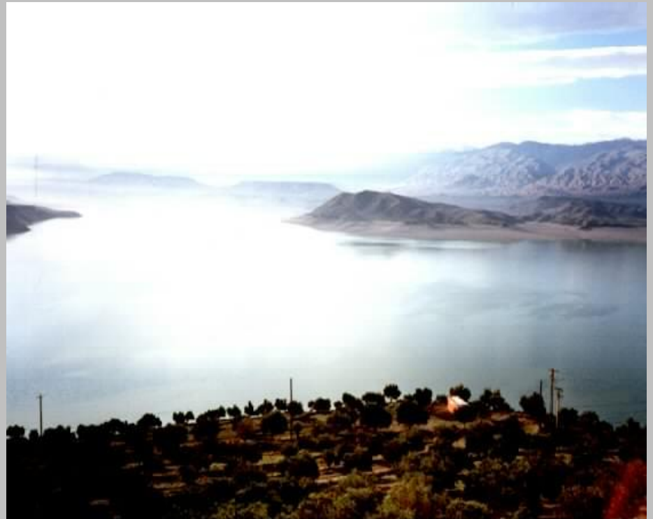
Запрудное водохранилище на р. Сефидруд (Иран)
