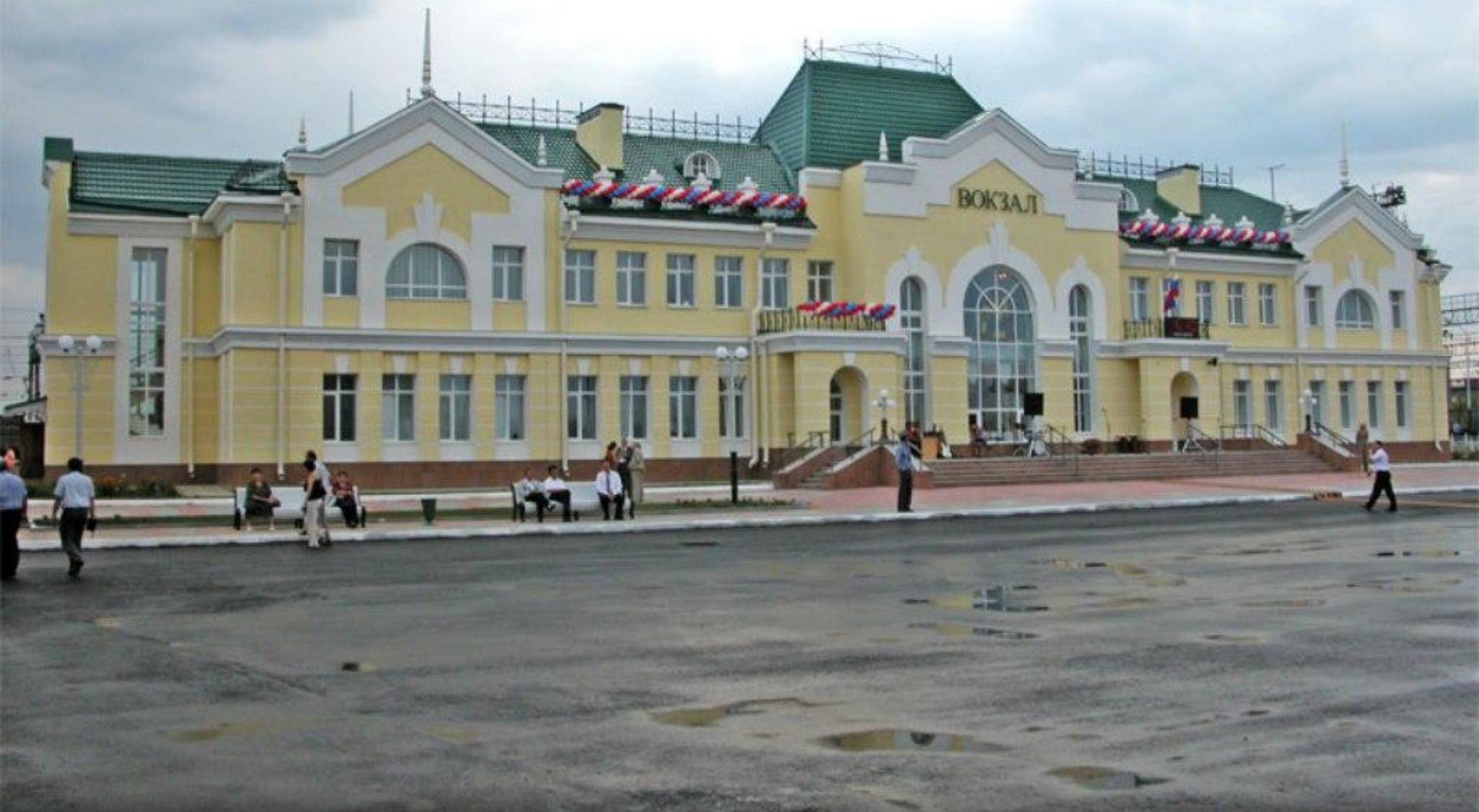
Реконструкция и капитальный ремонт вокзала станции Карасук (2005 г.)
