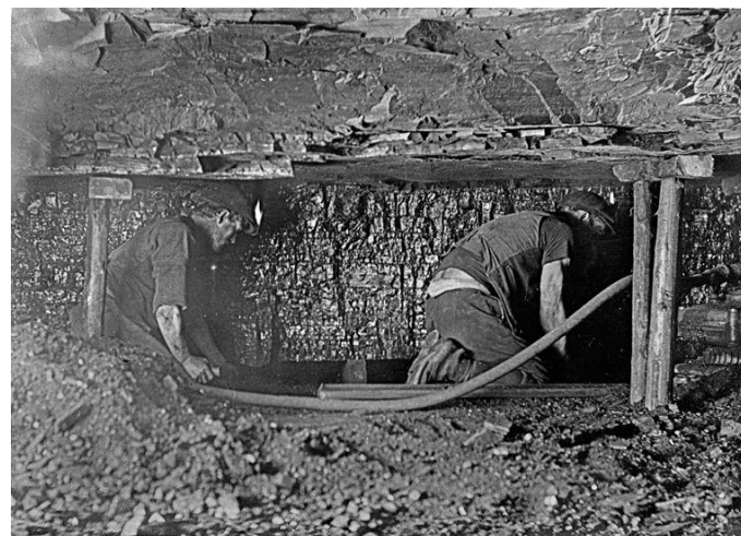
Деревянные шашки удерживают вруб
