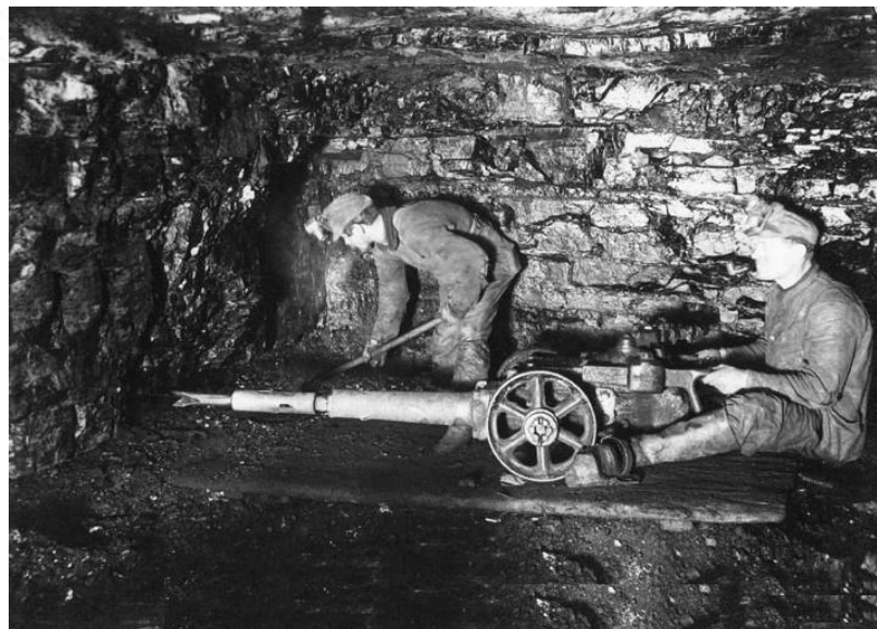
Перфораторная врубовая машина Sullivan с пневмоприводом 1900 г.
