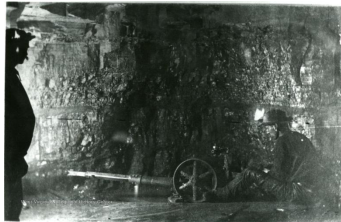
Перфораторная врубовая машина с пневмоприводом Sullivan
