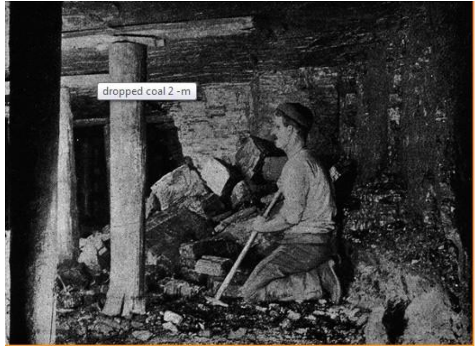
Разрушение подрубленного забоя
