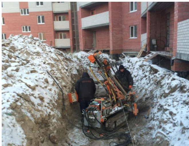
Рис.9 Выполнение работ по закреплению основания
