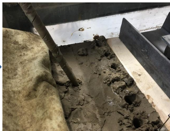
Рис.21 Процесс выбуривания грунта
