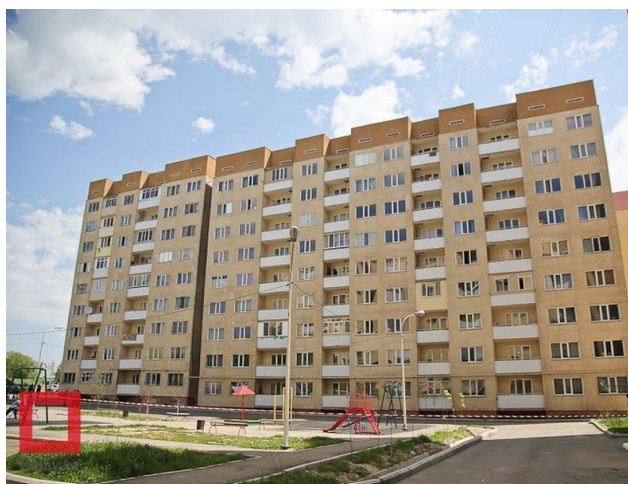
Рис.6 Жилой комплекс, г. Алматы, Казахстан
