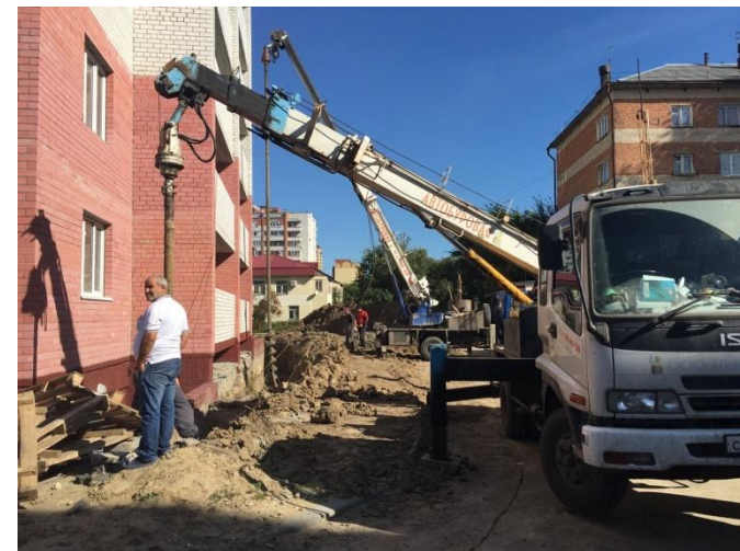
Рис.10 Выбуривание вертикальных скважин
