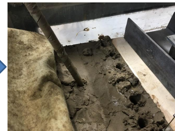
Рис.21 Процесс выбуривания грунта
