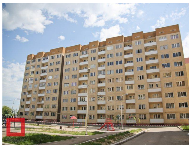
Рис.6 Жилой комплекс, г. Алматы, Казахстан
