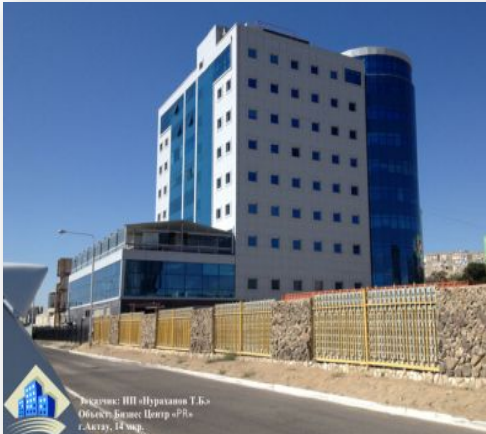
Бизнес комплекс «PR», 14 мкр.
