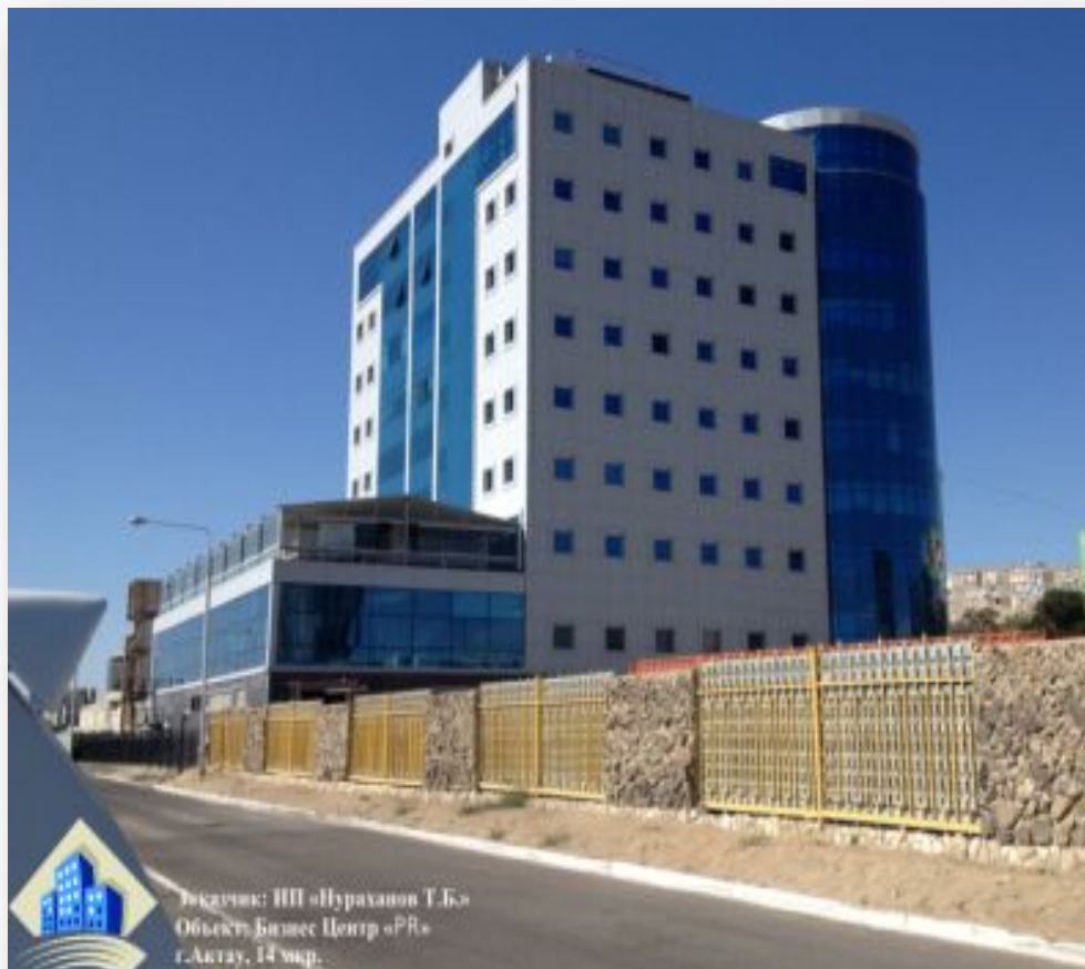
Бизнес комплекс «PR», 14 мкр.
