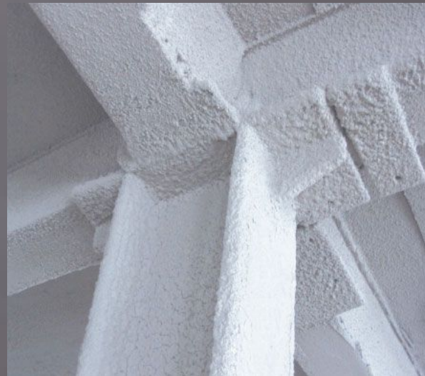
Покрытие негорящим раствором
