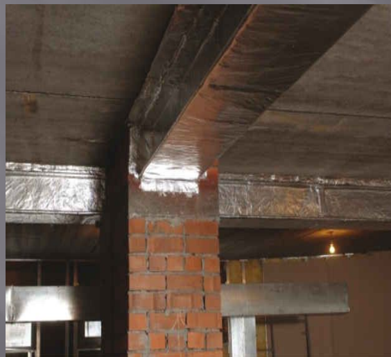
Обтяжка теплоизоляционным негорящим покрытием
