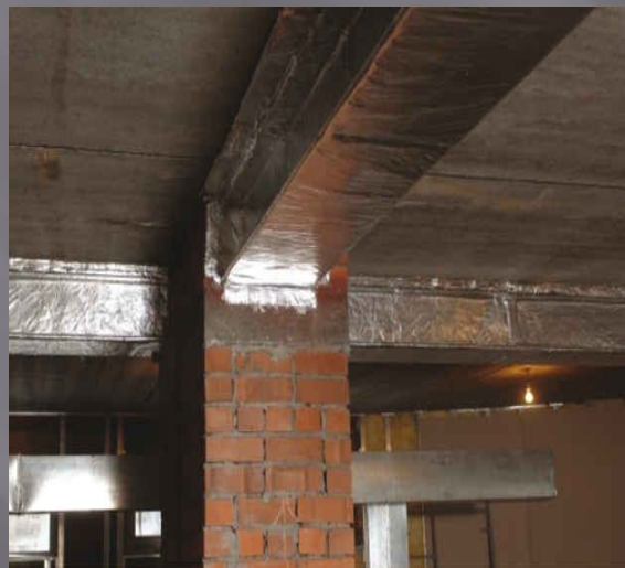
Обтяжка теплоизоляционным негорящим покрытием
