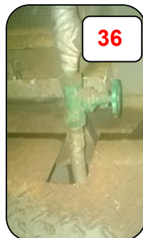
в районе санузла
