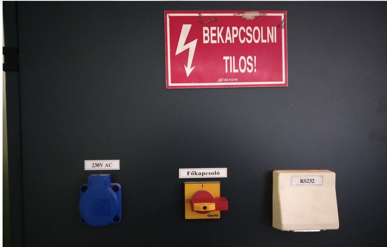
Розетка 220В. Выключатель. Интерфейс RS232.
