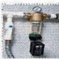
Фильтры для удаления механических примесей используются для осветления воды, улавливают крупные частицы; бывают фильтры грубой и тонкой очистки, работают благодаря материалу на основе алюмосиликатов. Недостаток этих фильтров: осуществляют только предварительную водоподготовку;
