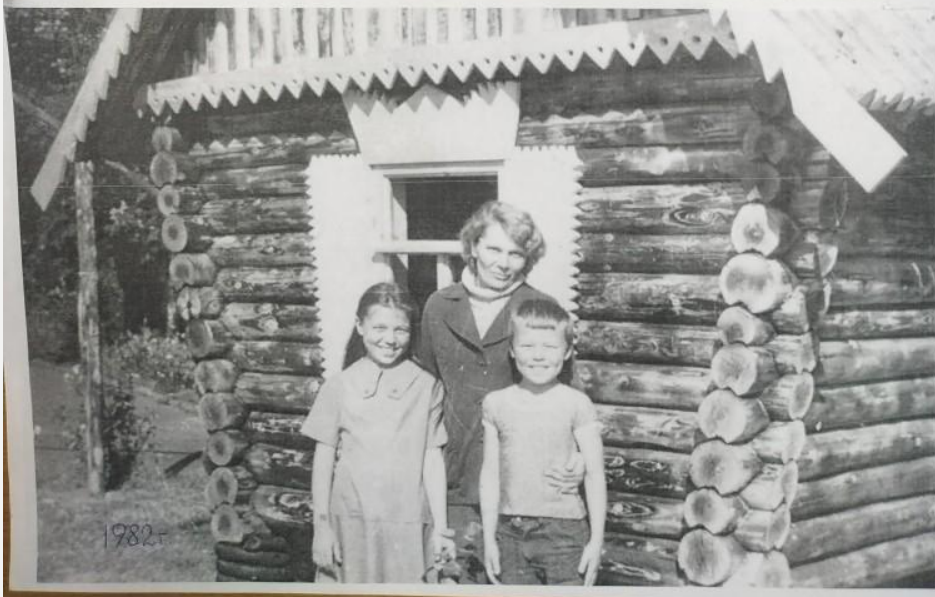
д.Новоселье, ... у магазина. Крыльцо было до строительства (поднятия) дороги. 1960-е г.
