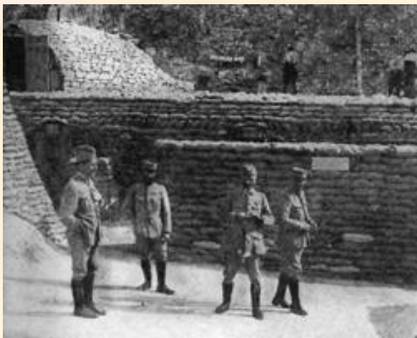
Французские оборонные сооружения, Сомма, 1916 г.
