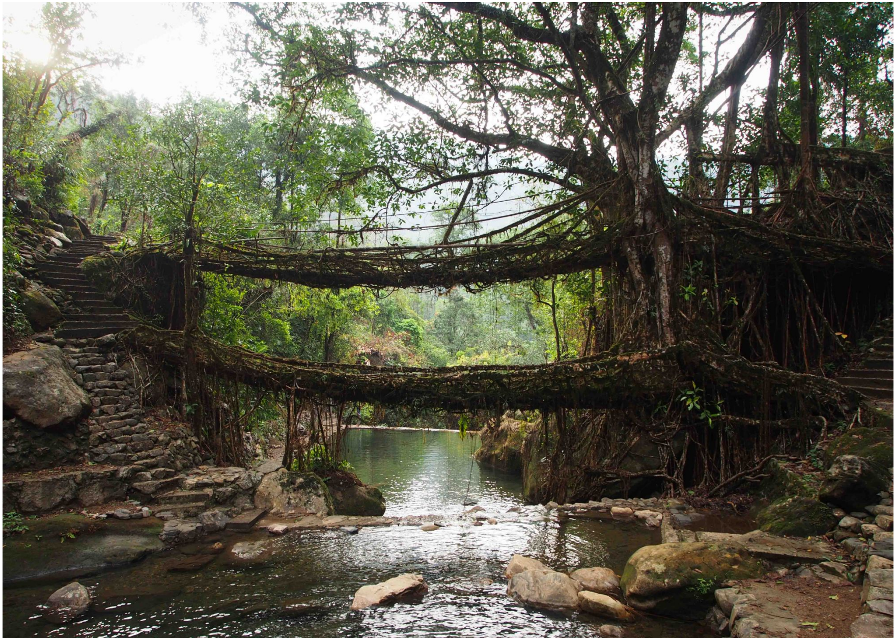
Рисунок 2. Мост Umshiang Двухэтажный
