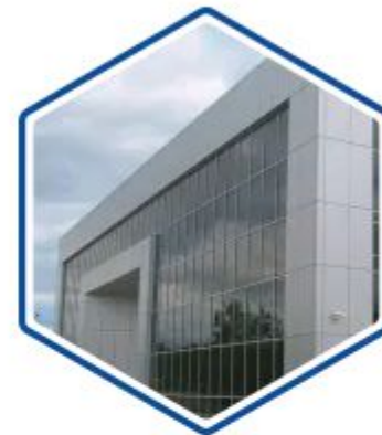
Промышленные здания и сооружения
