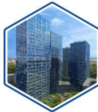
Жилые и общественные здания
