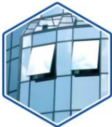
Дополнительная вентиляция здания
