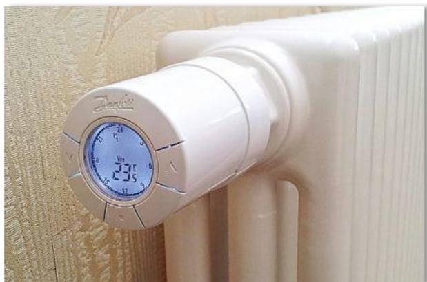
**Терморегулятор** - система, позволяющая регулировать уровень подачи тепла в отопительный прибор.
