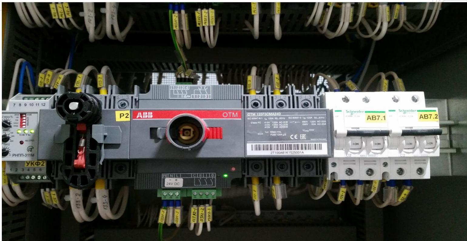
Реализация функции автоматического и ручного Вывасс.
