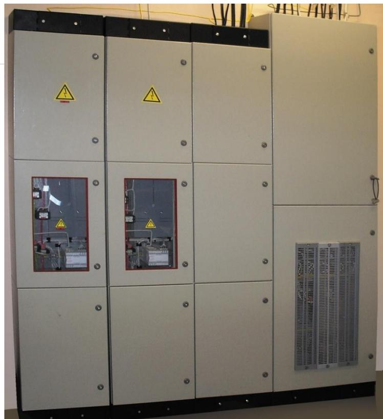
Дефицит производственных площадей вызывает необходимость реализации оборудования в модульном исполнении по принципу конструктора LEGO с односторонним обслуживанием, а затрудненные условия транспортировки оборудования к месту монтажа требует снижения массогабаритных показателей устройств.
