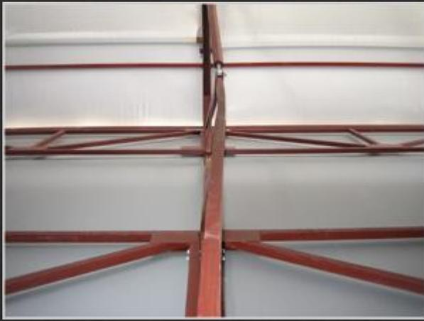
Сопоставление зафиксированных разрушений с результатами расчетов. Фотография элемента конструкции, потерявшего устойчивость
