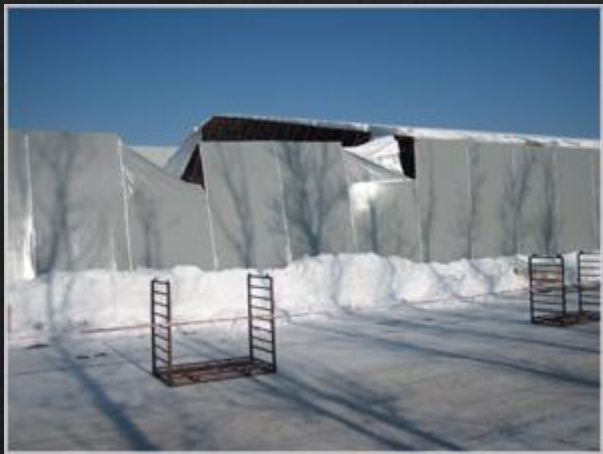
Сопоставление зафиксированных разрушений с результатами расчётов
