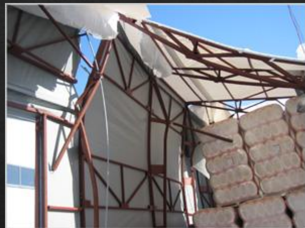
Сопоставление зафиксированных разрушений с результатами расчётов
