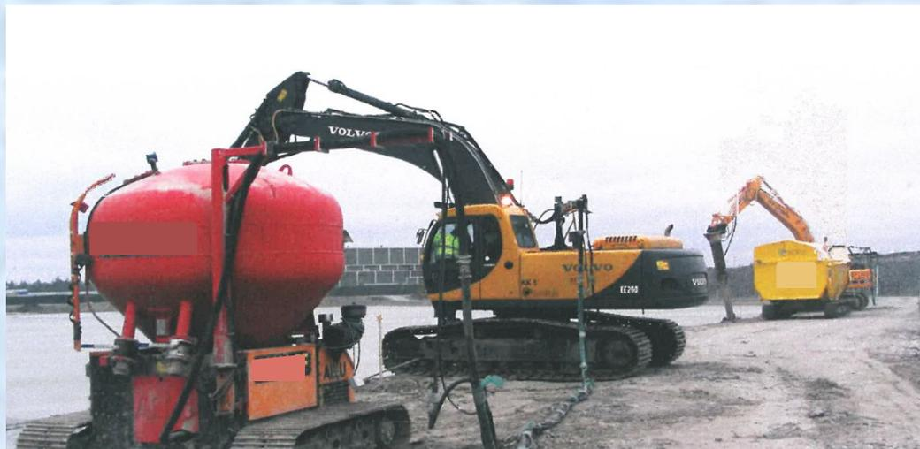
*При увеличении объемов работ СПАСФ «Природа» планирует использовать промышленные перемешиватели для экскаваторов и пневмо системы подачи цемента.*
