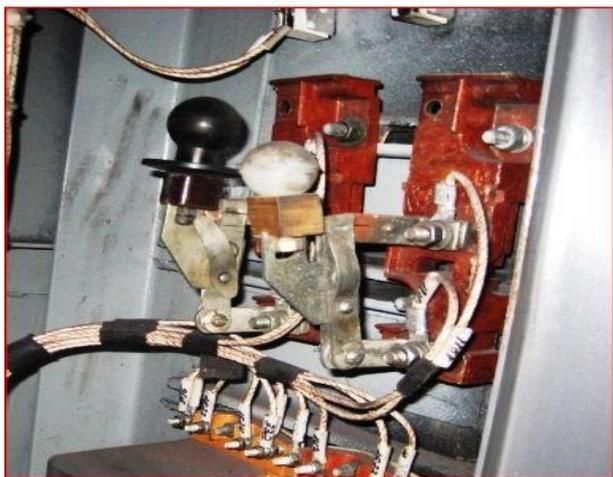
*Дополнительные резисторы СР36 и СР35 (1823-1822) в цепи рабочей катушки служат для уравнивания чувствительности при замыкании на корпус в (+) и (-) цепях.*
