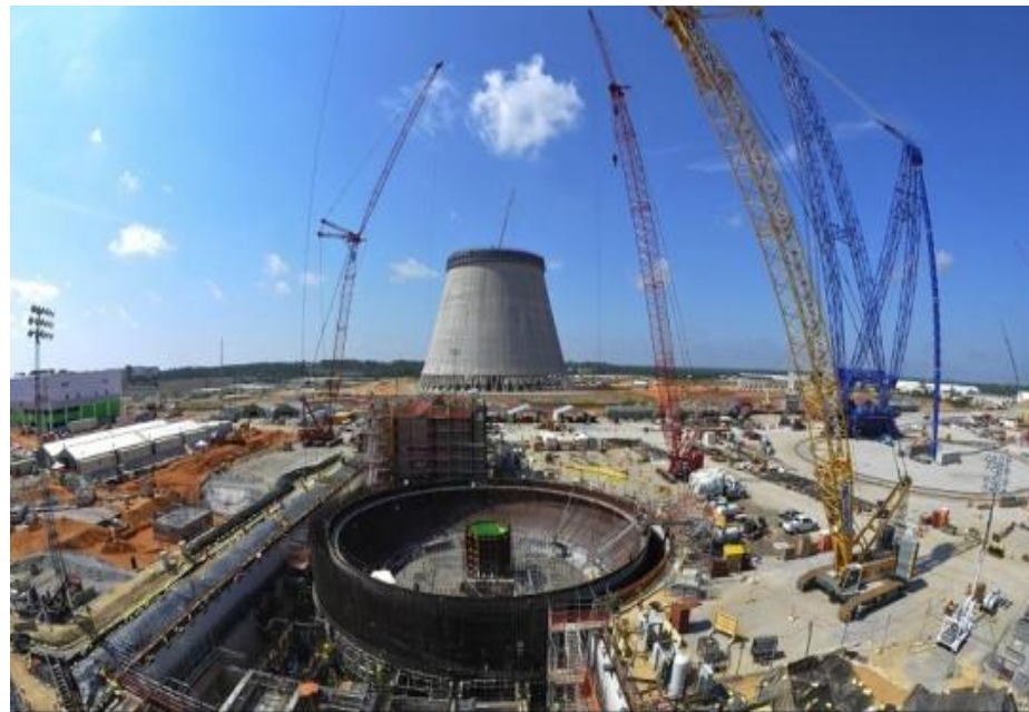
Рисунок 8. Строительство Балтийской АЭС.
