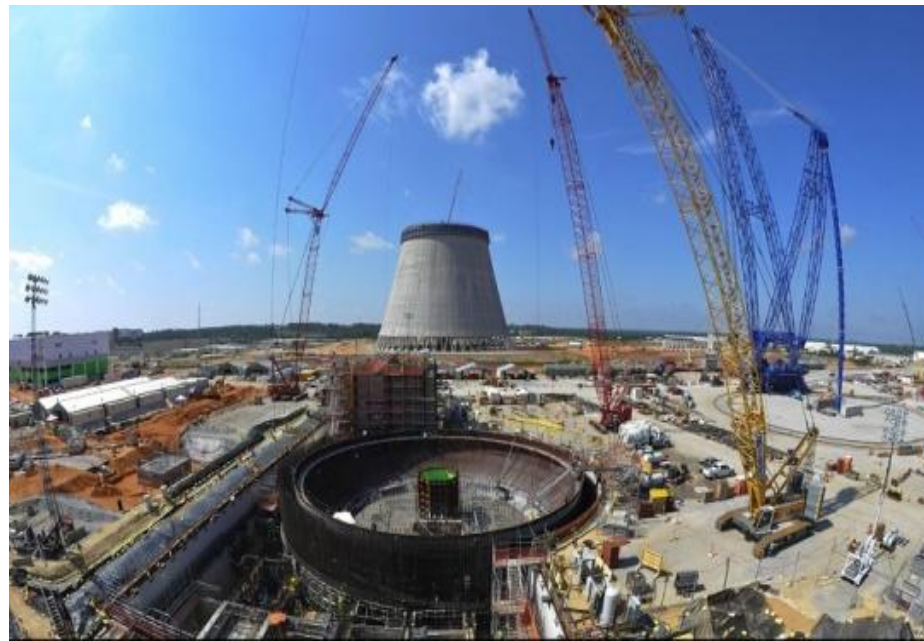
Рисунок 8. Строительство Балтийской АЭС.
