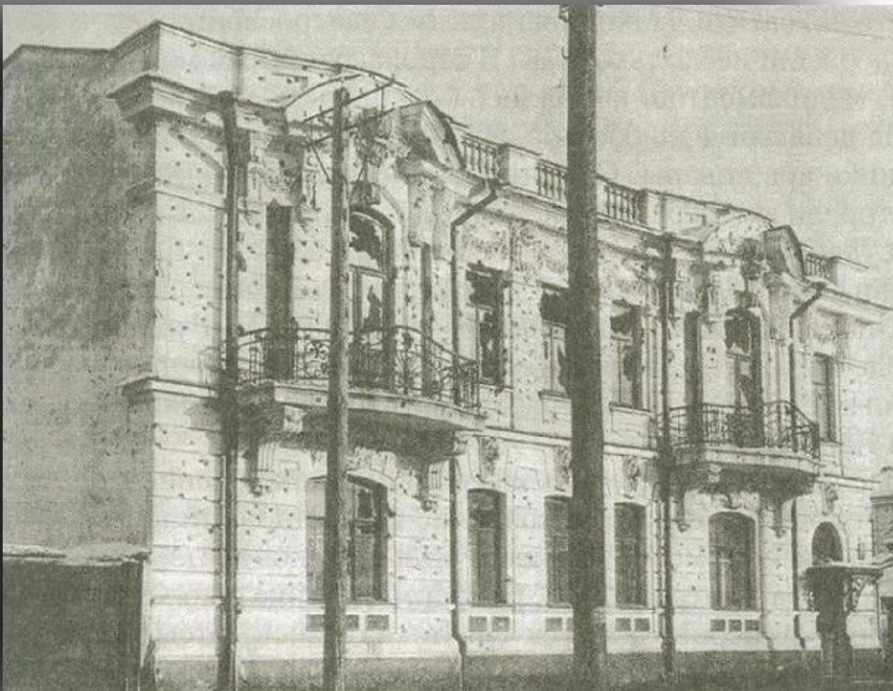
особняк П. И. Гернандта (70-е годы XIX века). Сейчас в здании располагаются центр и служба по сохранению объектов историко- культурного наследия по Иркутской области. Ул 5 Армии. д2
