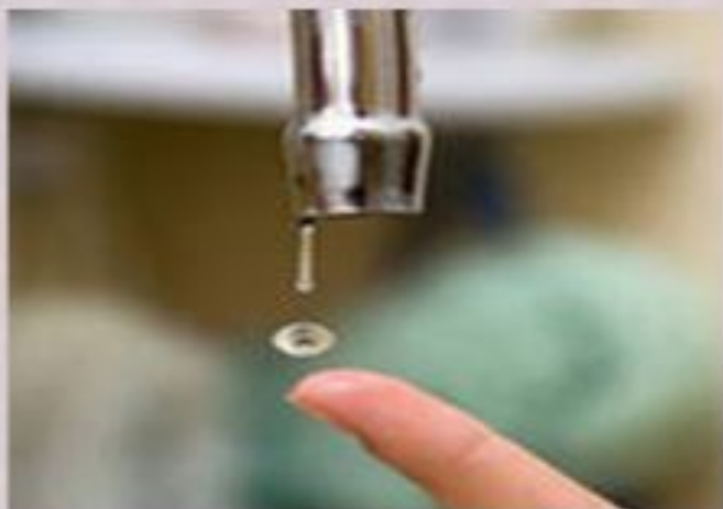
в системах водоснабжения
