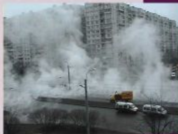
на системах теплоснабжения
