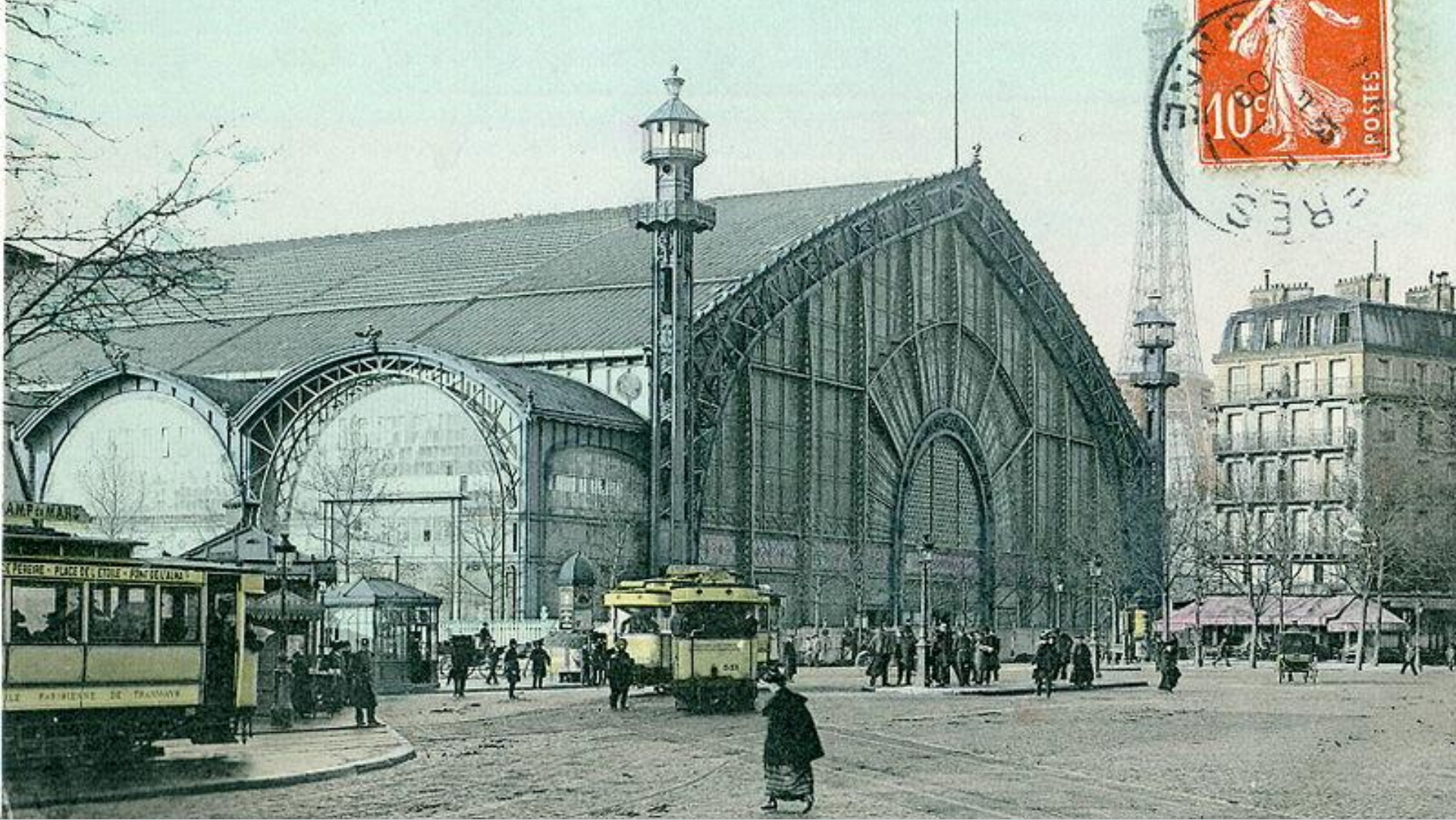
528. PARIS — Galerie des Machines C. L. C.
