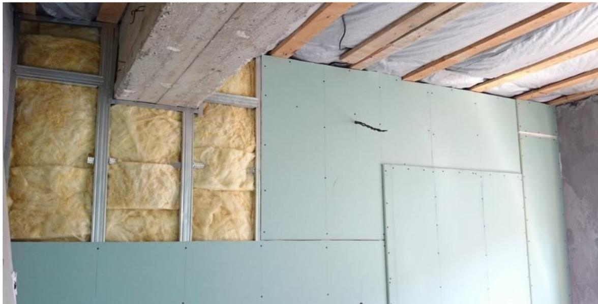
При облицовке плиткой по обшивке из гипсокартонных листов шаг стоек каркаса должен быть не более 400 мм, а обшивку следует предусматривать двухслойной.
