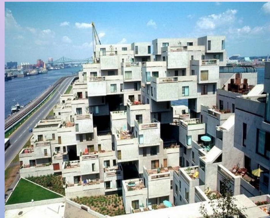
Жилой комплекс «Хабитат» на Экспо-67 в Монреале
