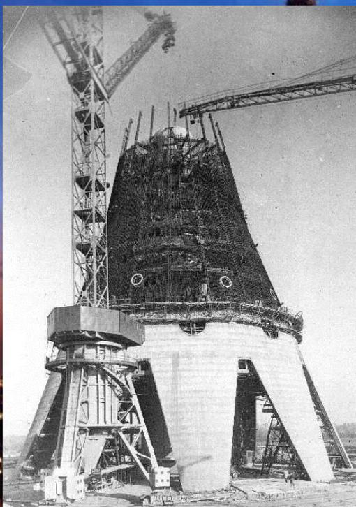
Идея использовать преднапряжённый железобетон, сжатый стальными тросами, позволила сделать конструкцию башни простой и прочной. Другой прогрессивной идеей было использование относительно мелкого фундамента: **по замыслу Никитина башня должна была практически стоять на земле** и ее устойчивость обеспечивается за счет многократного превышения массы шлема-основания над массой мачтовой конструкции.
