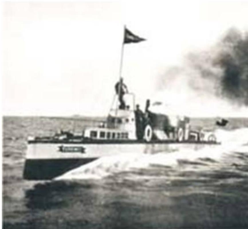
Первое судно с паротурбинным двигателем – «Турбиния», - построенное Парсонсом в 1894 году развивало скорость около 59 км/час. С 1900 года турбины начали устанавливать на миноносцах, а после 1906 года все большие военные корабли оснащались турбинными двигателями.
