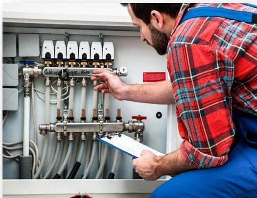
Балансировка системы отопления
