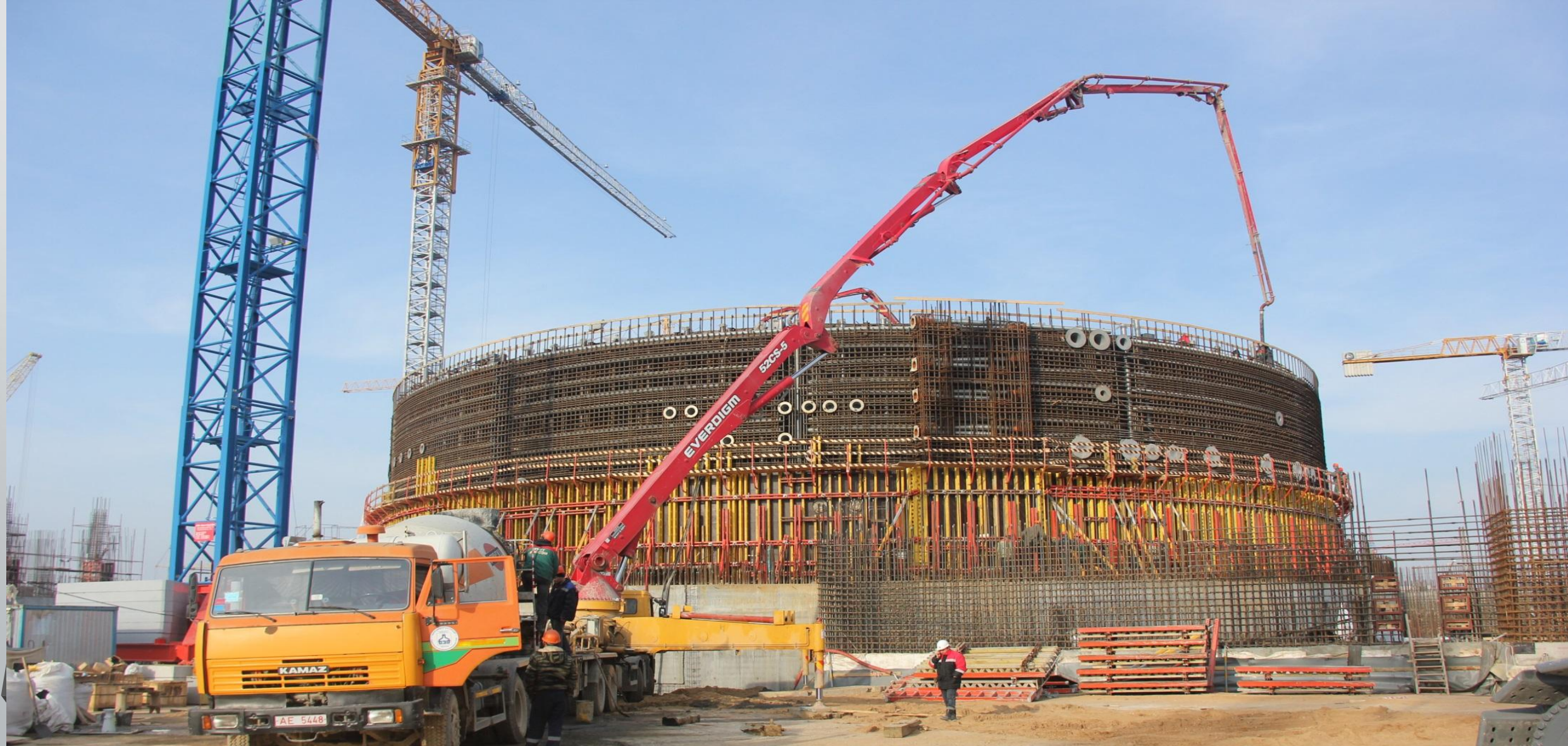
Ноябрь, 2014 г. Бетонирование внутренней защитной оболочки 1
