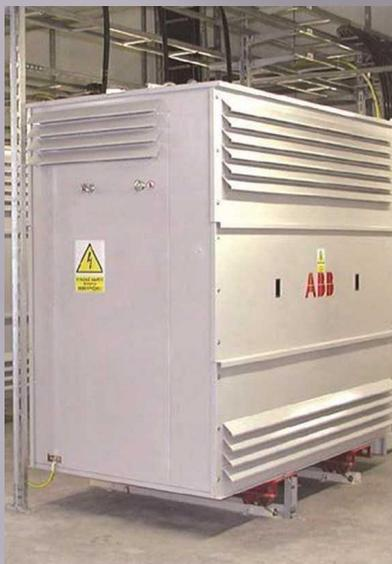
Два сухих трансформатора СН Resibloc 10/0,4 кВ мощностью 250 кВА IP23
