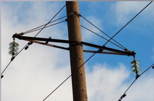
ВЛ 35 кВ выполнена на стеклянных изоляторах. Изоляция на вновь устанавливаемых опорах ВЛ 35 кВ принята также стеклянной. Выбор изоляции произведен с учетом степени загрязнения атмосферы. На ВЛ 35 кВ степень загрязнения атмосферы – вторая. Выбраны:
