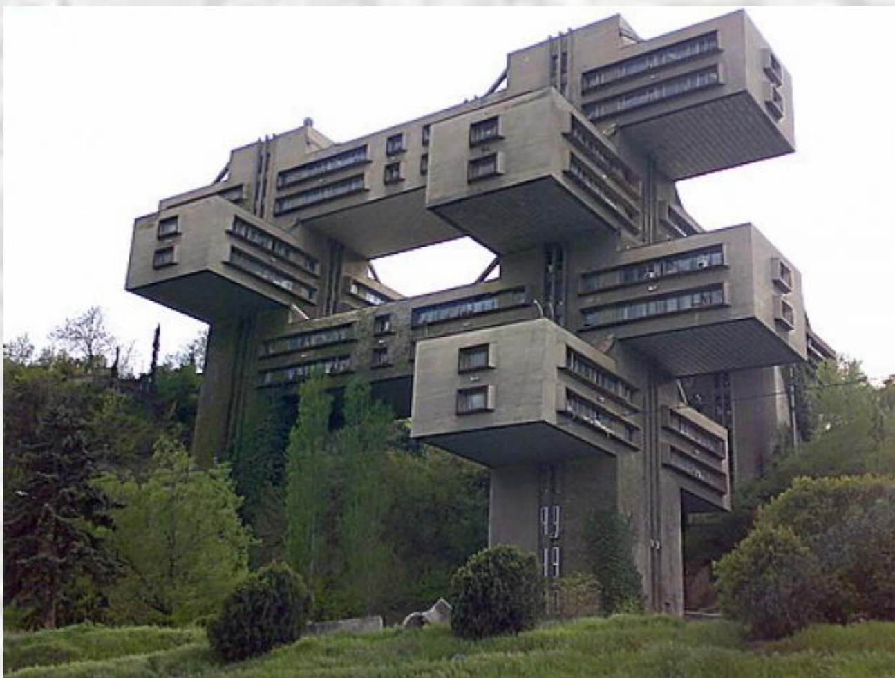
Инженерный корпус Министерства автомобильных дорог, Тбилиси, Грузия
