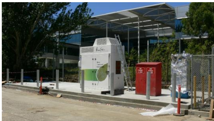
В Австралии, испытательная установка для автомобилей, работающих на природном газе
