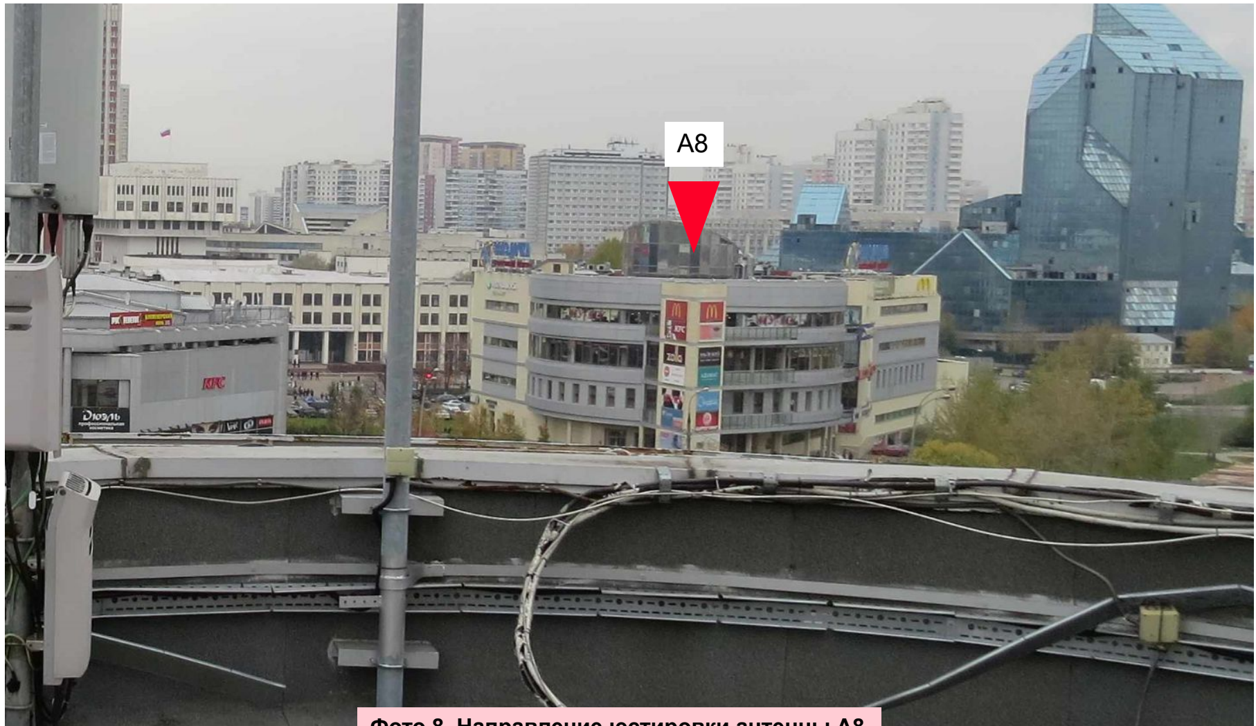
Фото 8. Направление юстировки антенны A8
