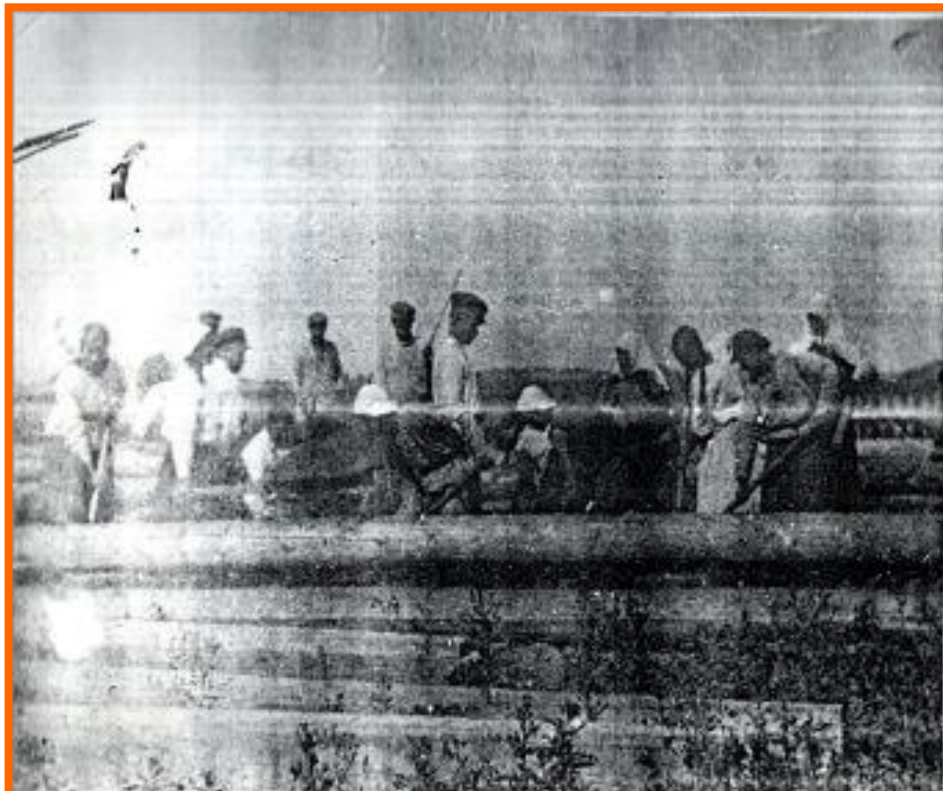
На строительстве народного дома
