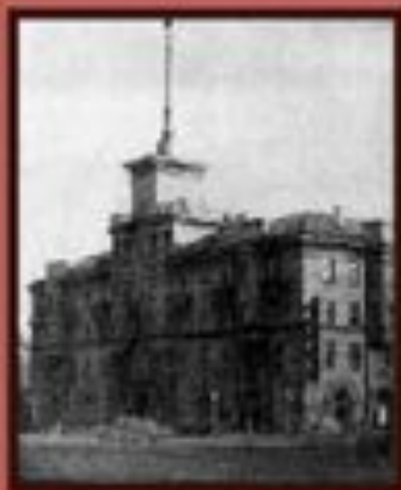
Жилой дом «под шпилем» на Октябрьской площади. 195
