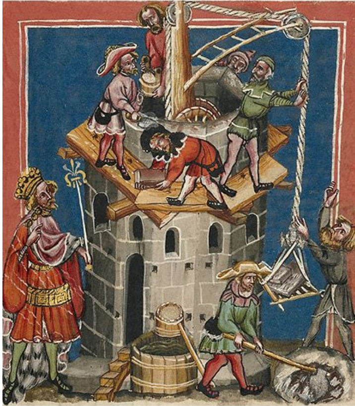
Строительство средневекового собора
