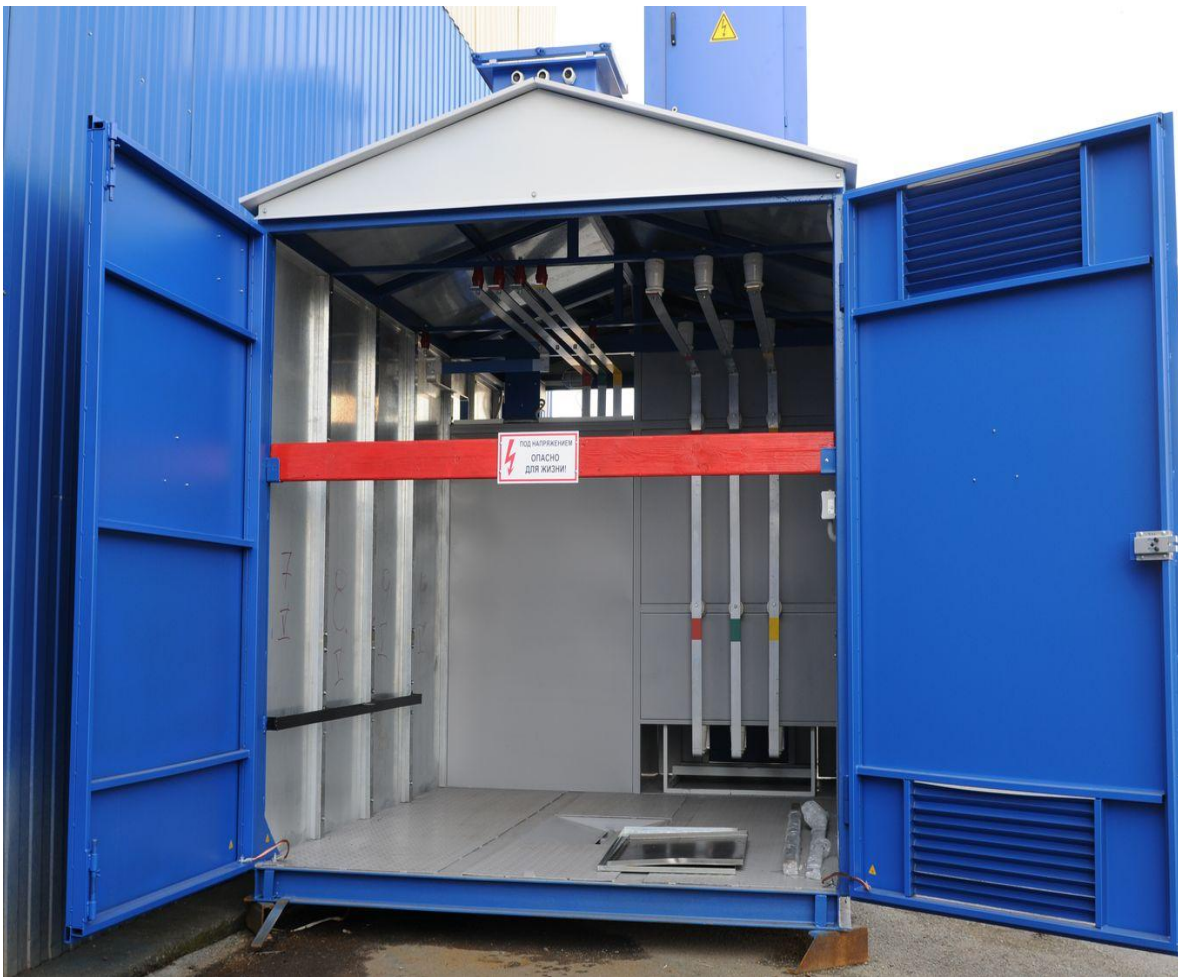
трансформаторный отсек
