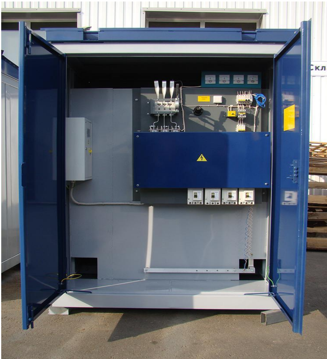
распределительное устройство низкого напряжения 0,4 кВ
