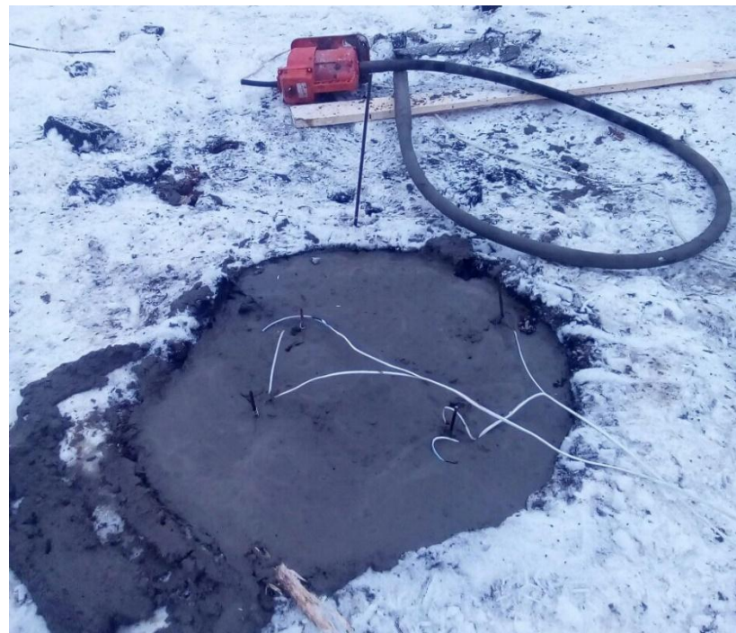
фундамент под колонну каркаса
