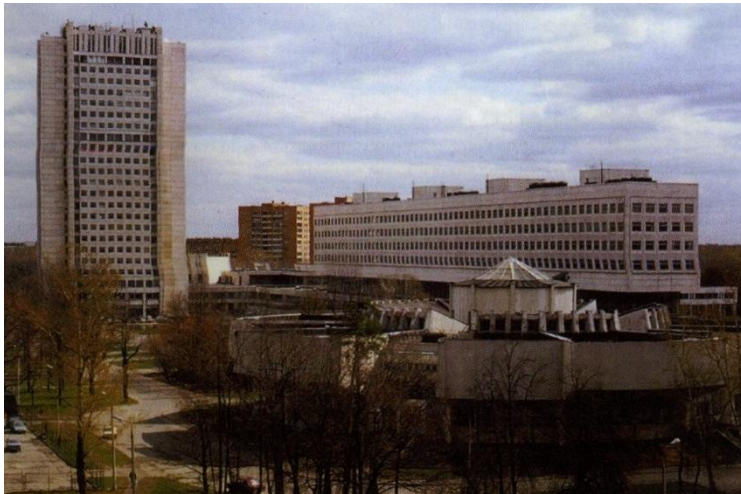
Здание МГСУ на Ярославском ш., д.26
